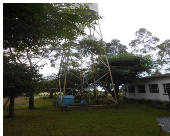
Barra do Ijuí/Tratamento e Reservação
