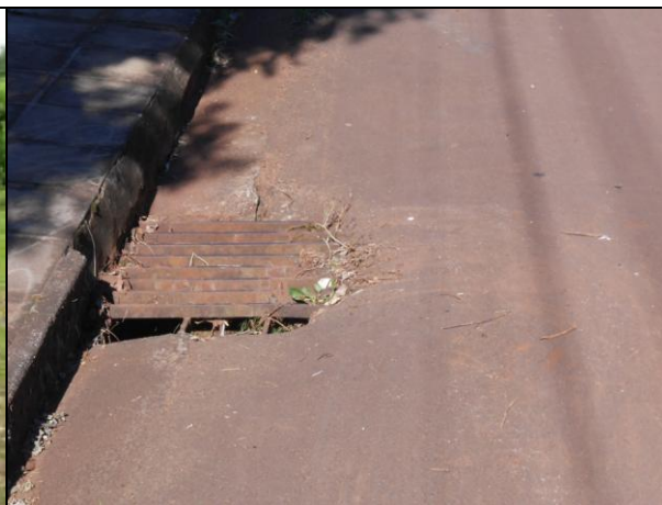
FOTO 02 – Boca de Lobo
